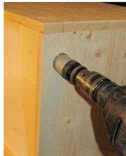
**5.** Zwei Luftlöcher mit einem Durchmesser von ca. 4 cm zwischen Boxoberkante und Kistenoberkante in die Seitenwand bohren
